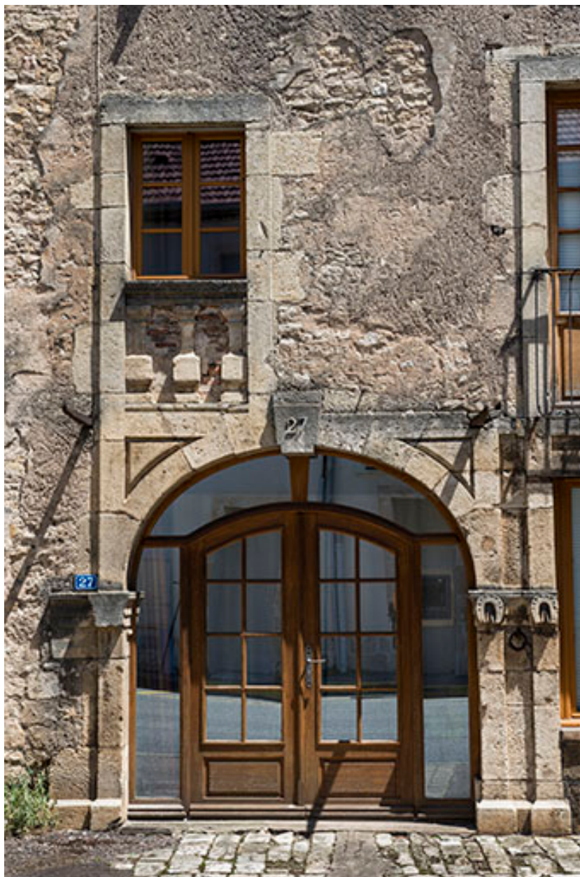
Baies du rez-de-chaussée et du premier étage.
