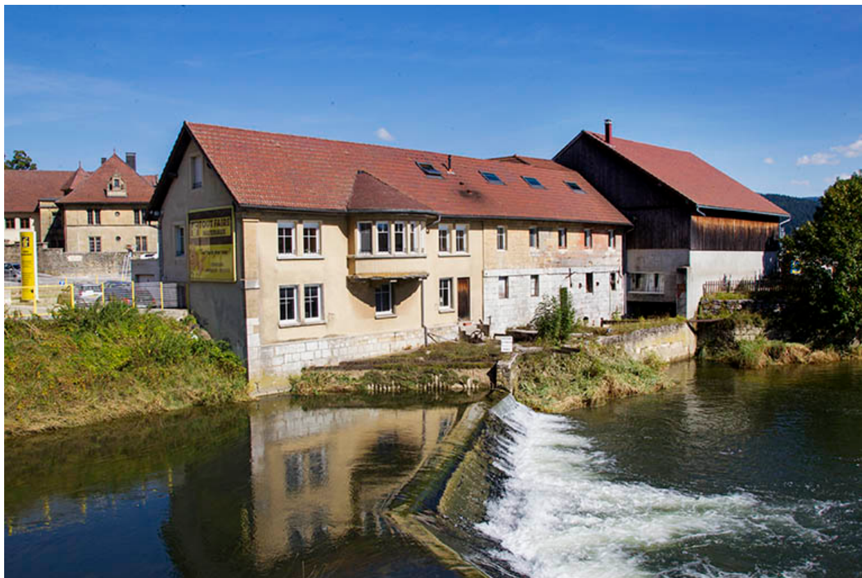
Façades postérieure et latérale droite.
