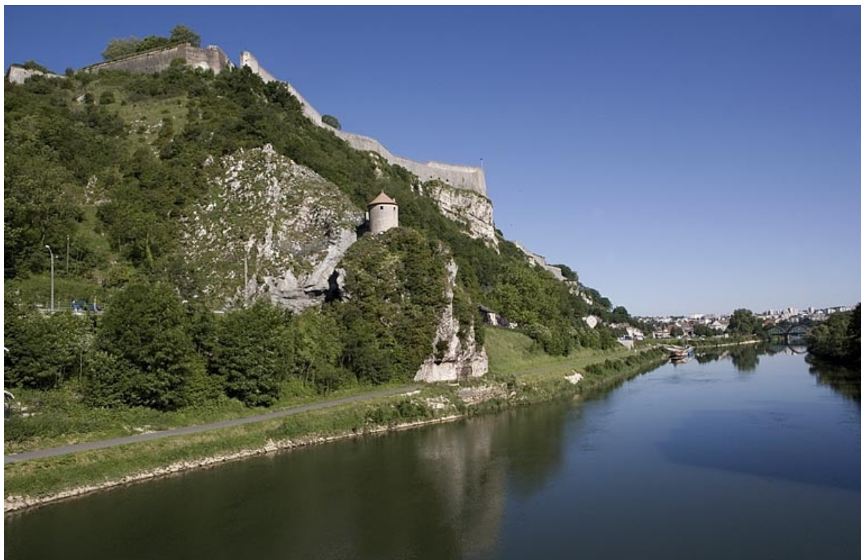
Vue d'ensemble du quai depuis l'amont.
