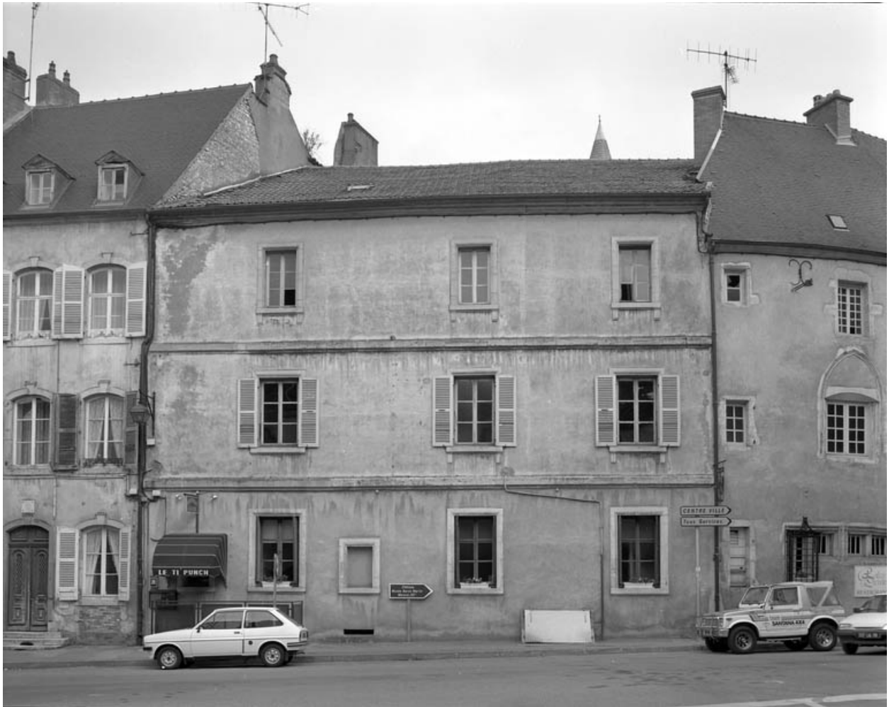
Bâtiment central : façade antérieure, de face.
