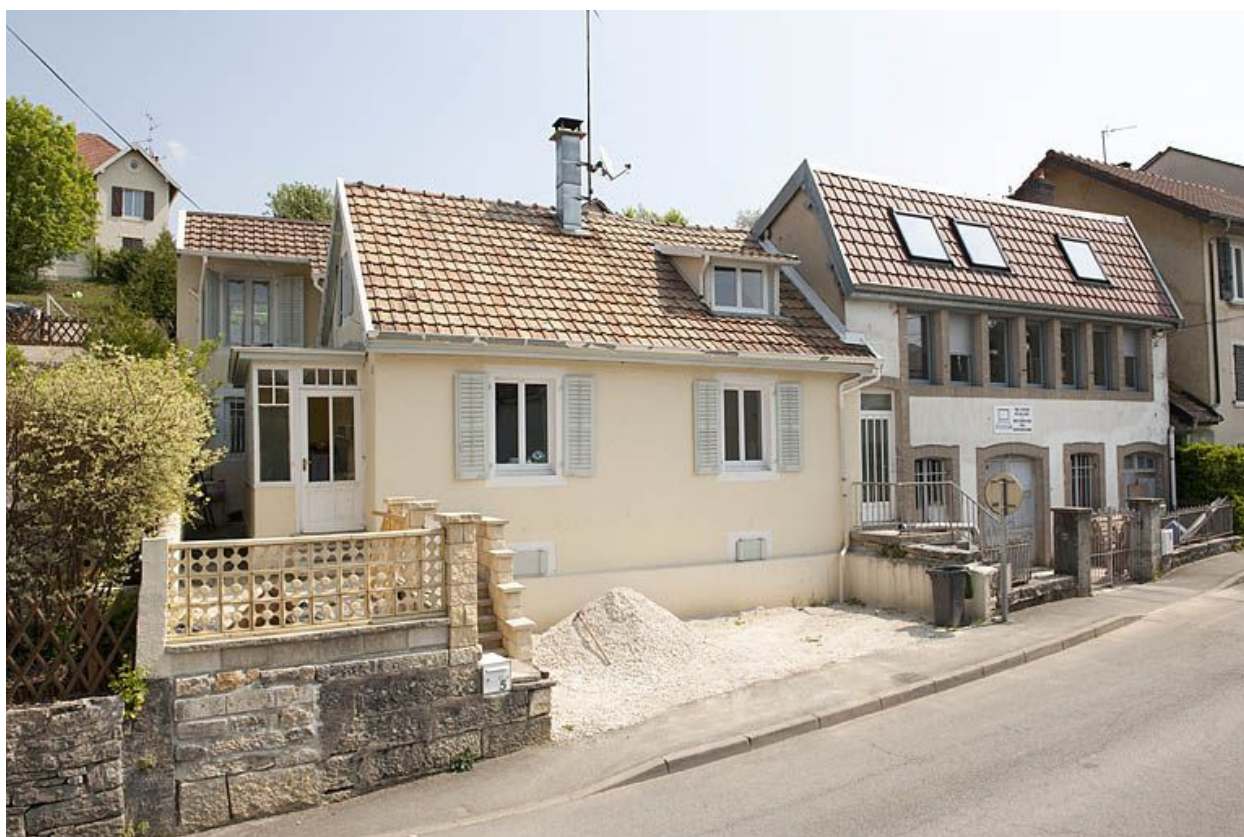
Logement et atelier depuis le nord-ouest.
