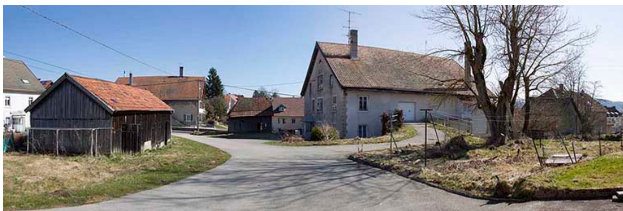
Vue d'ensemble du site, depuis l'ouest.
