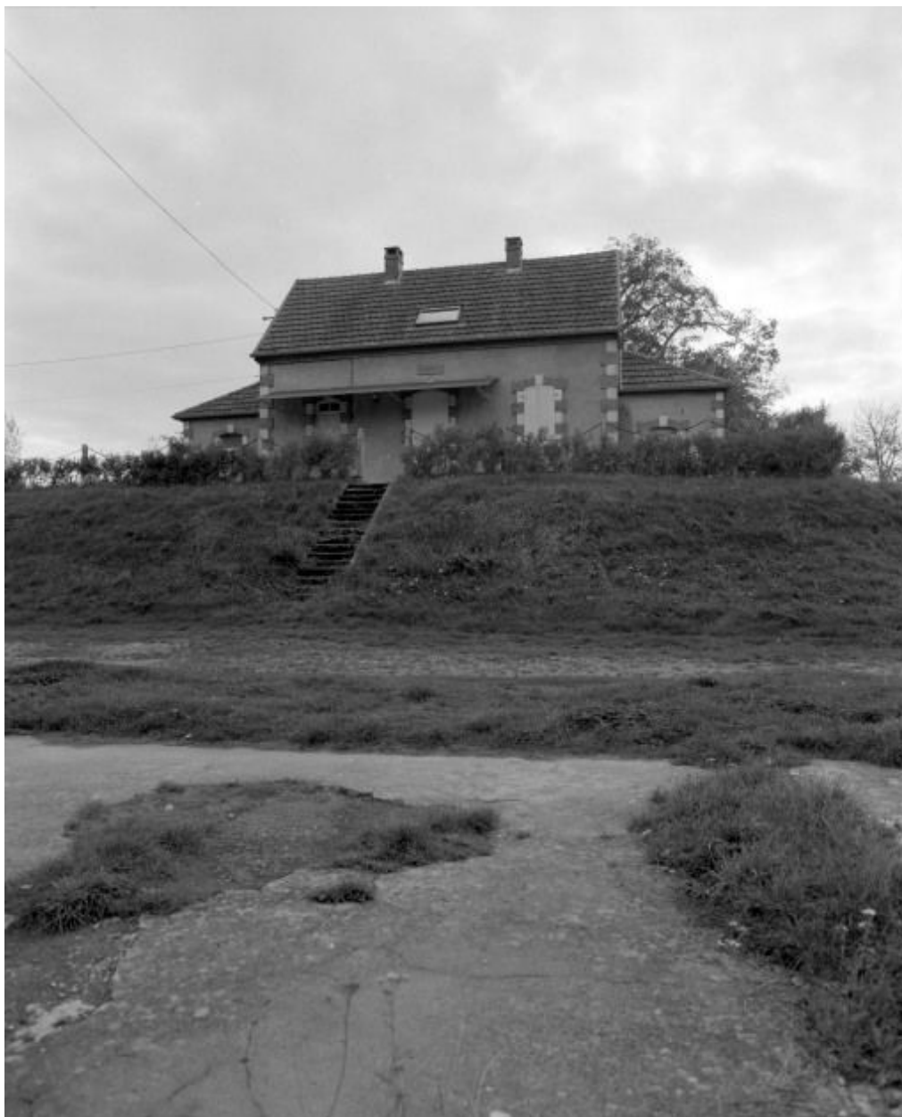
La maison du barragiste (en 2001).
