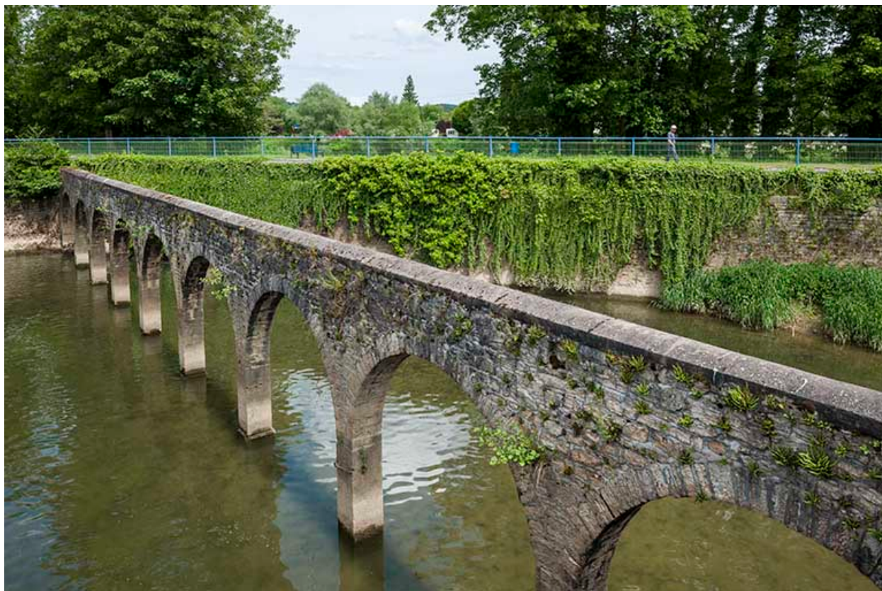
Arcades enjambant l'ancien canal de fuite.
