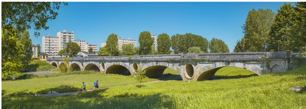
Le pont des Chavannes, vu d'aval.
