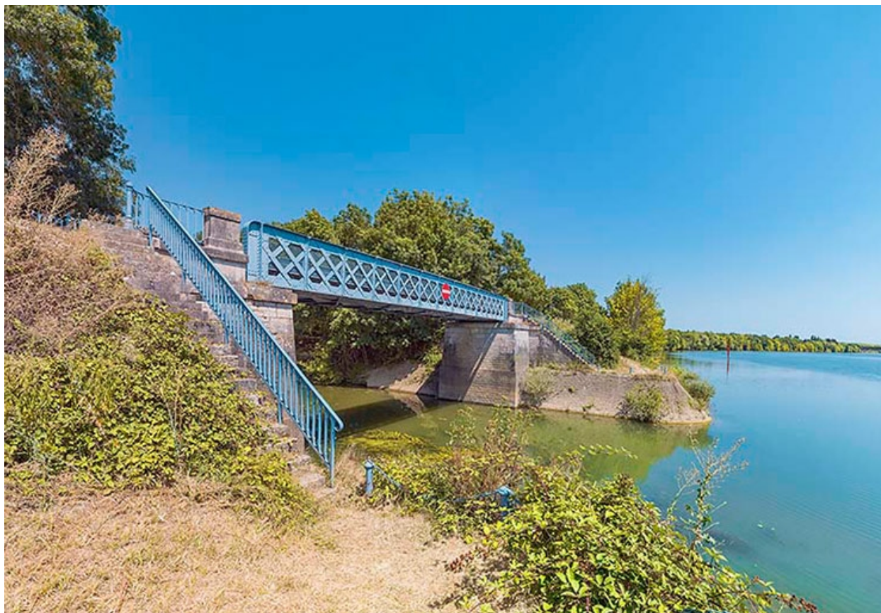
Vue d'ensemble du pont sur la Dheune.
