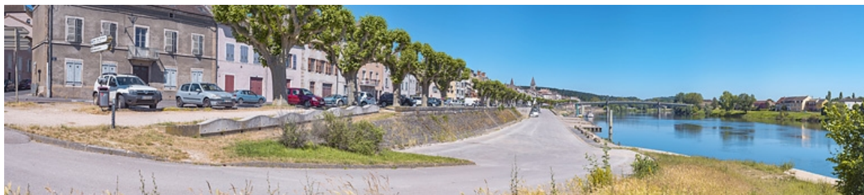
Vue d'ensemble du quai sud.
