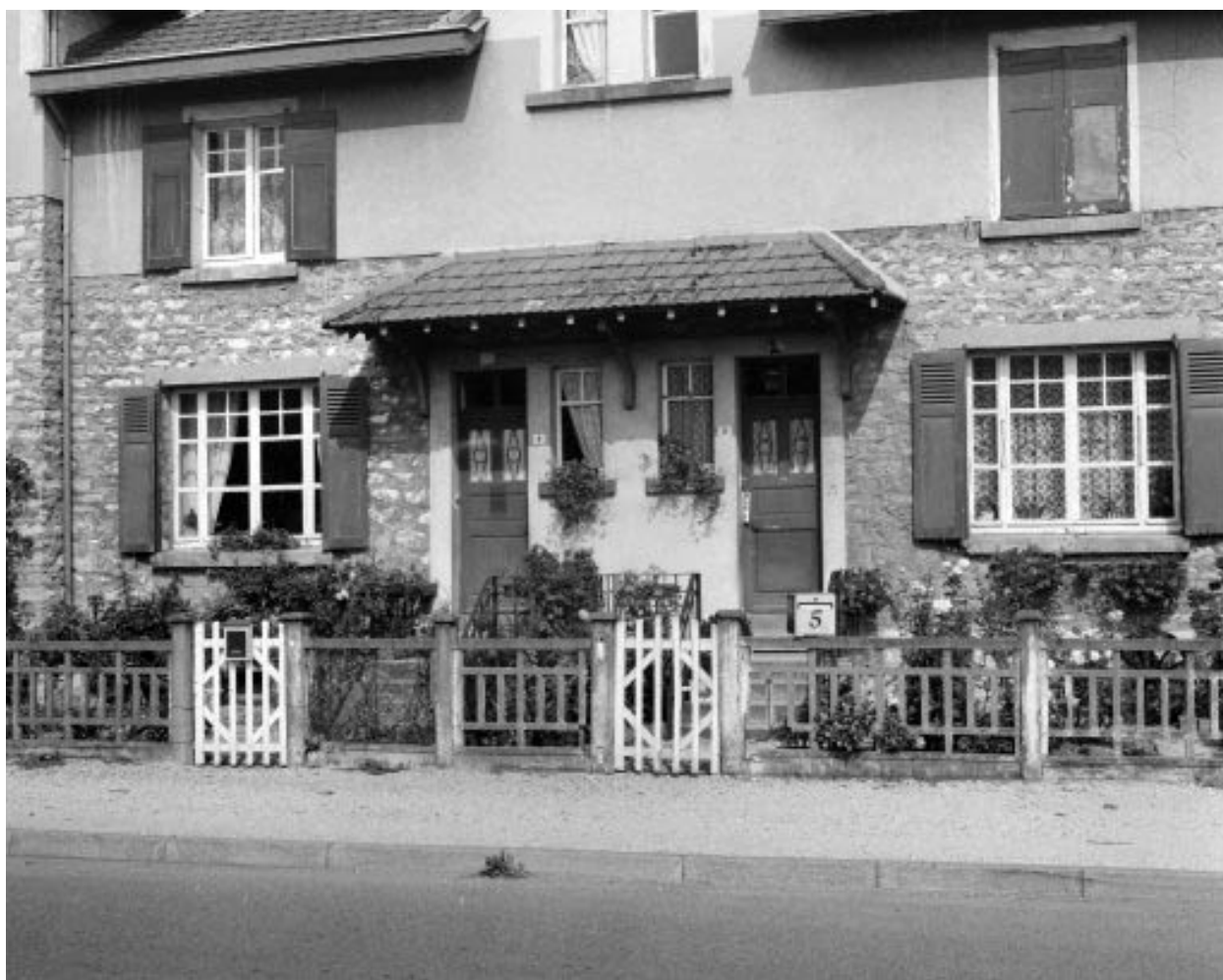
Façade antérieure, détail.
