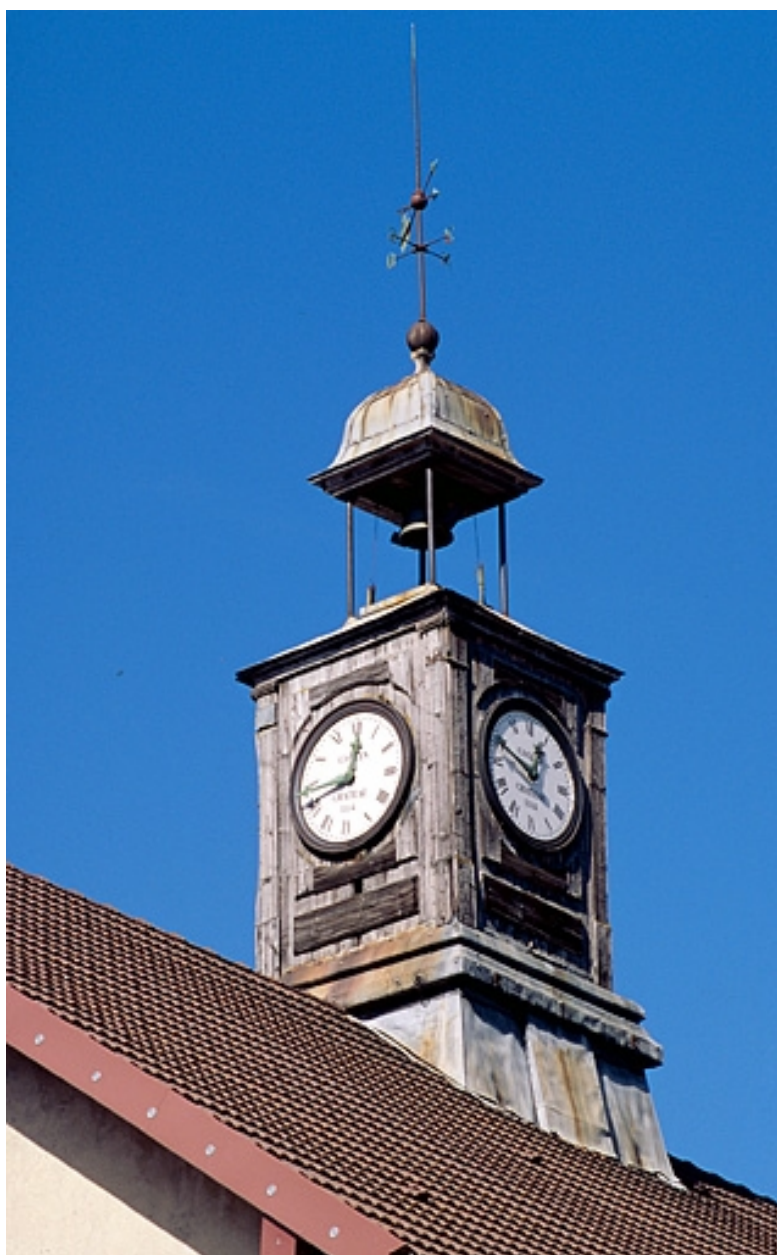
Foncine-le-Haut : clocheton de l'usine d'horlogerie Château.
