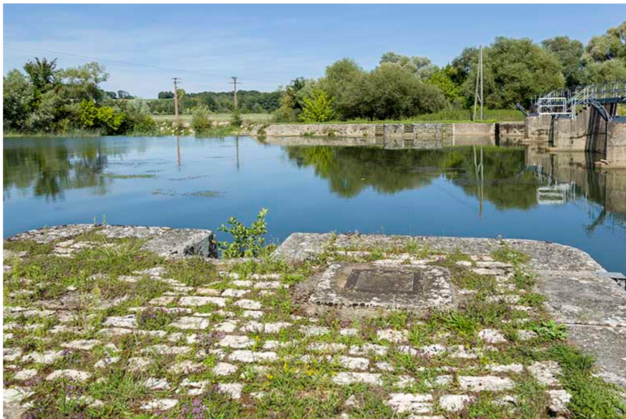
Emplacement de l'ancien barrage à aiguilles.
