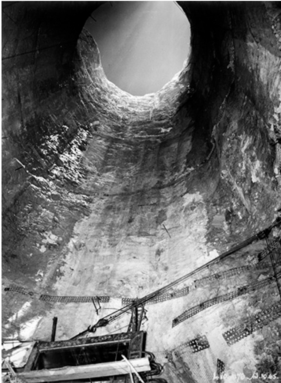
Puits 1-2, sommet entonnement 1.
