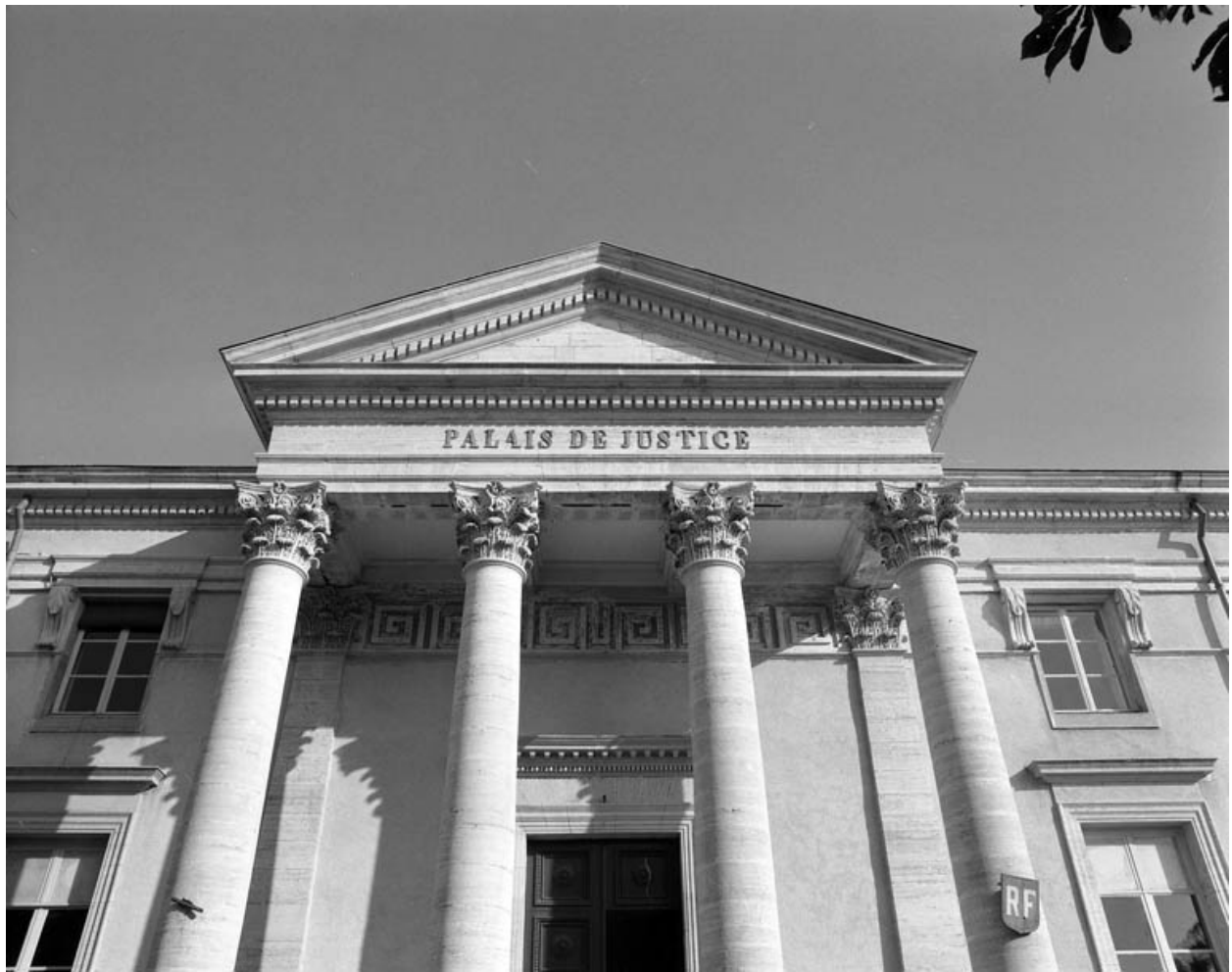
Façade antérieure : avant-corps central de face.
