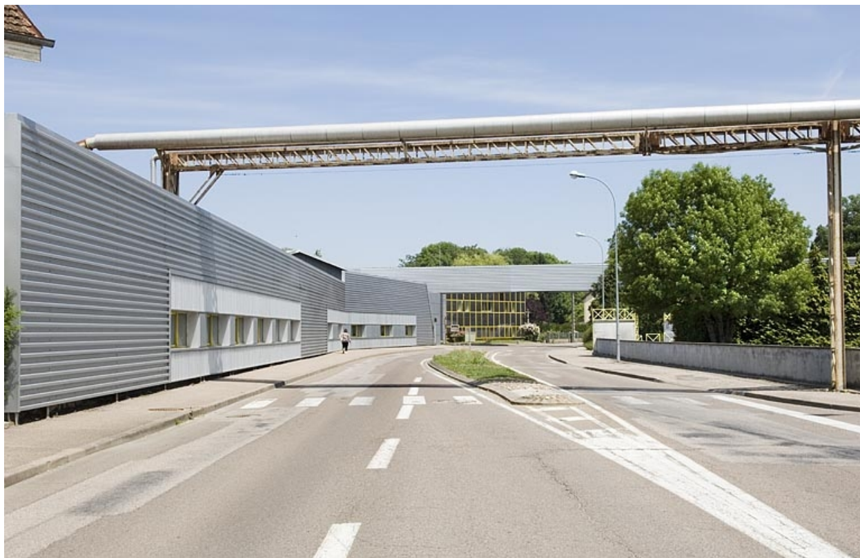
Vue de l'usine depuis l'avenue Jacques Parisot.
