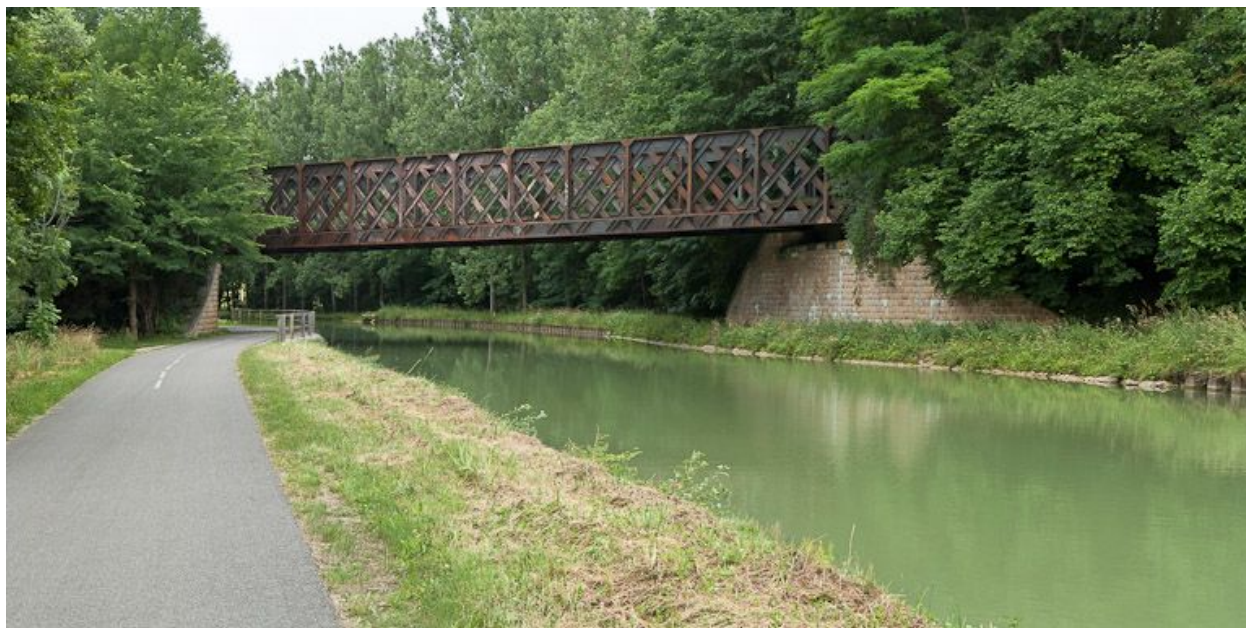
Vue d'ensemble du pont ferroviaire.
