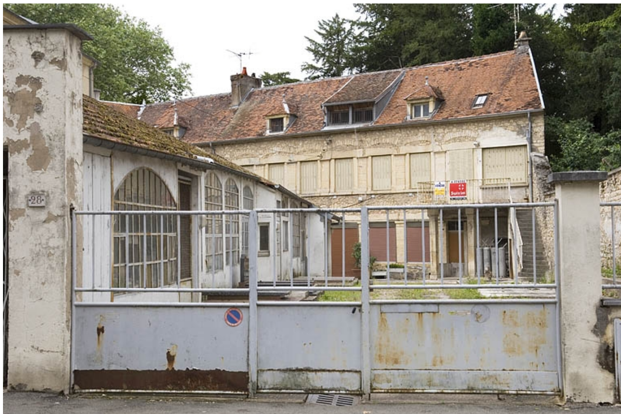
Vue d'ensemble depuis la rue Victor Hugo.
