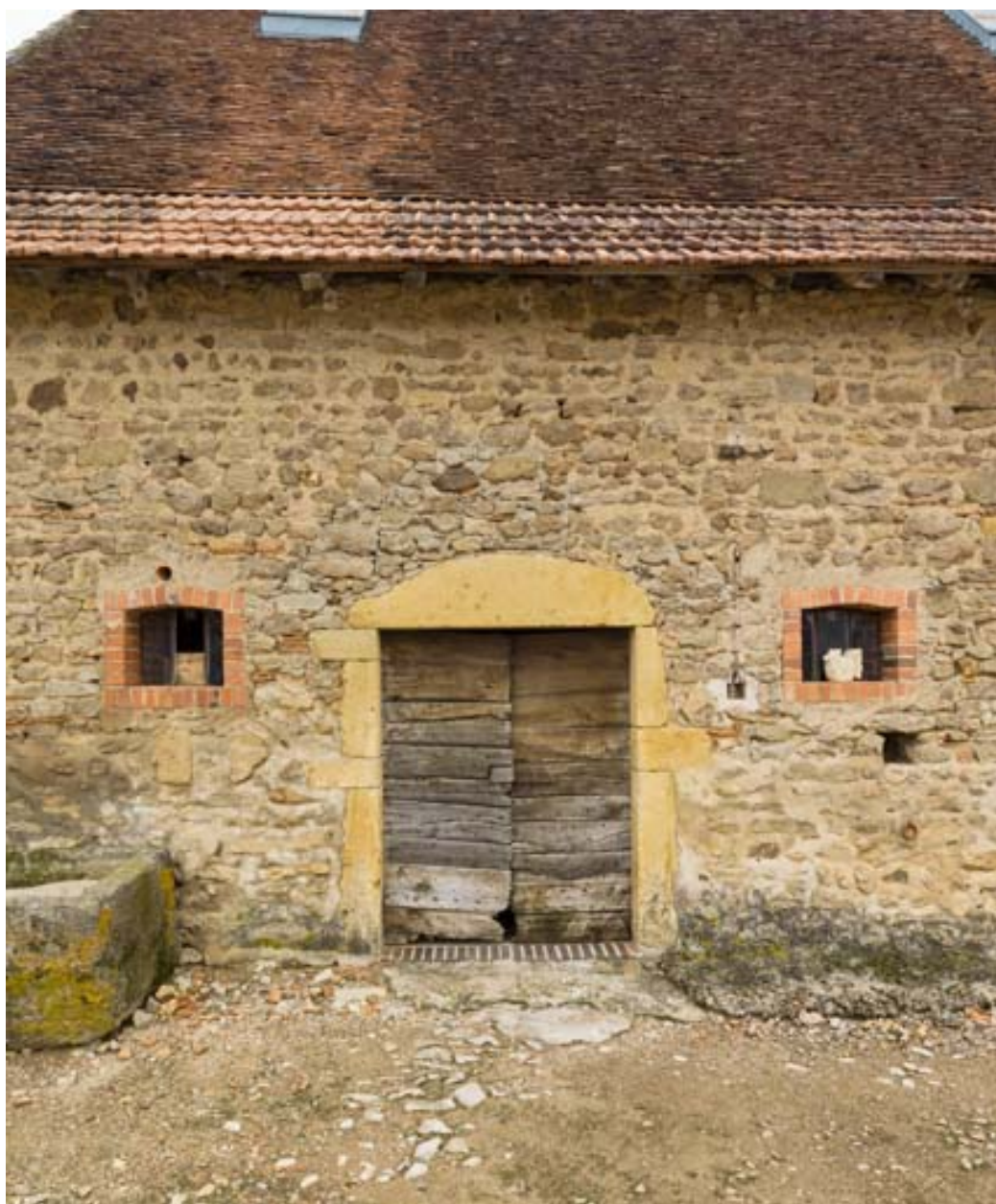
Etable. Détail de la travée ouest.
