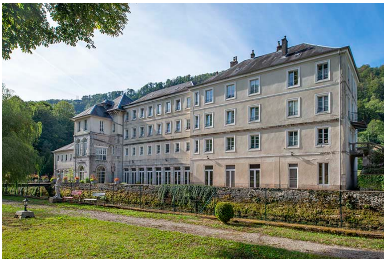
Façade principale, vue de trois quarts.
