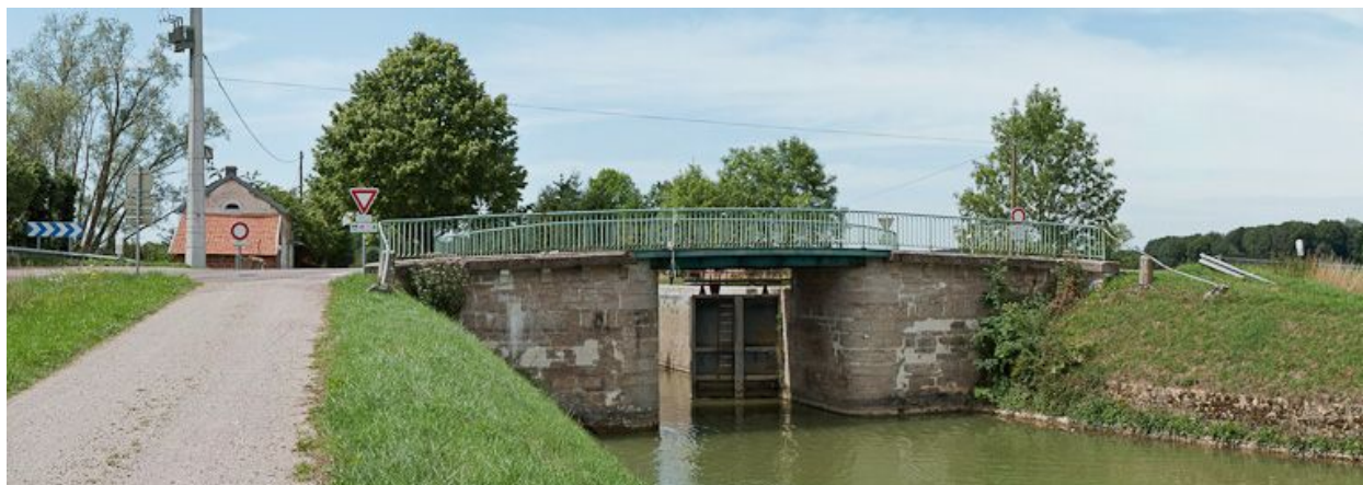
Vue du pont depuis l'aval.
