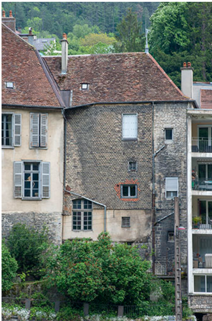
Extrémité sud de la façade occidentale.
