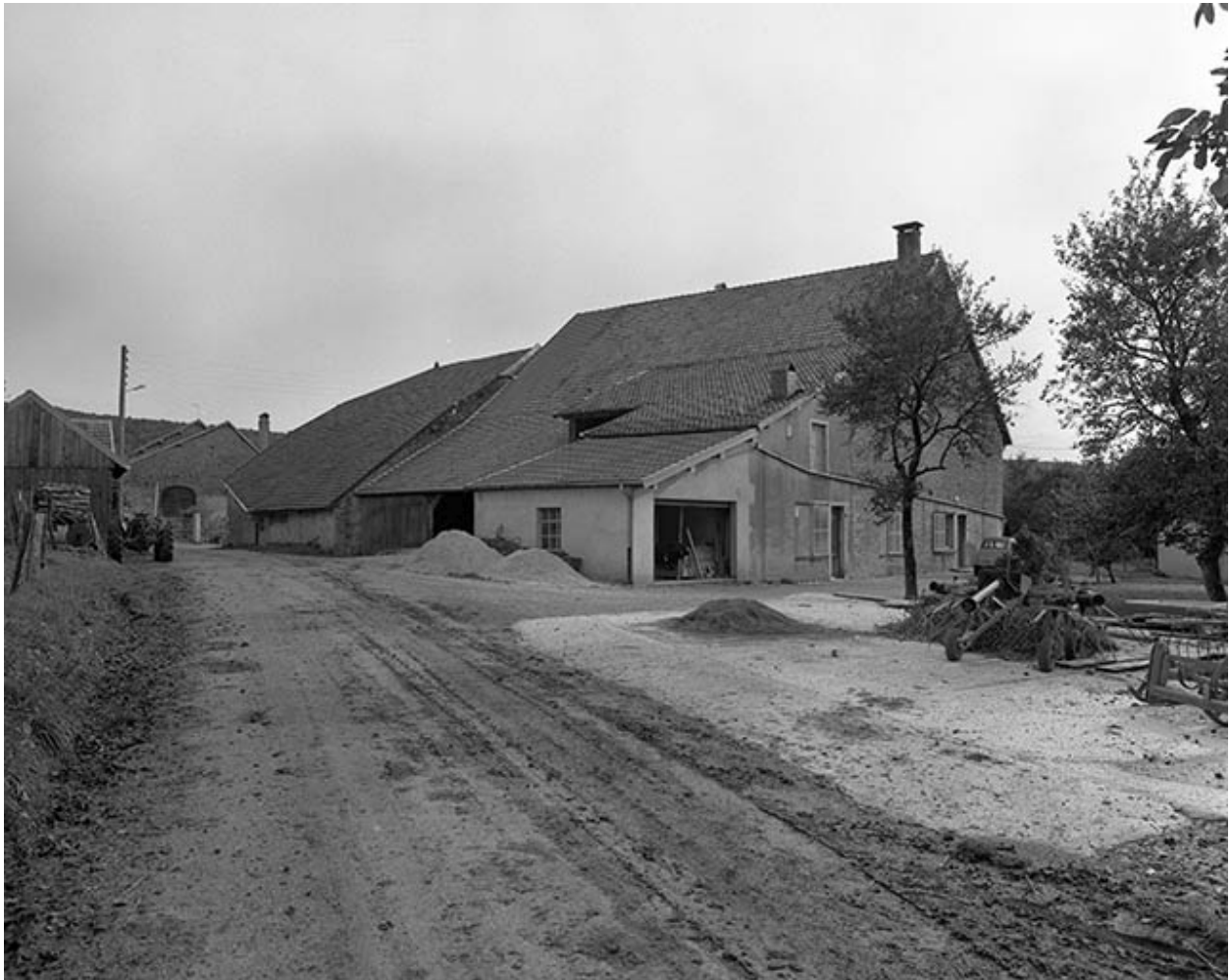
Ferme située 5 rue de Naglans.
