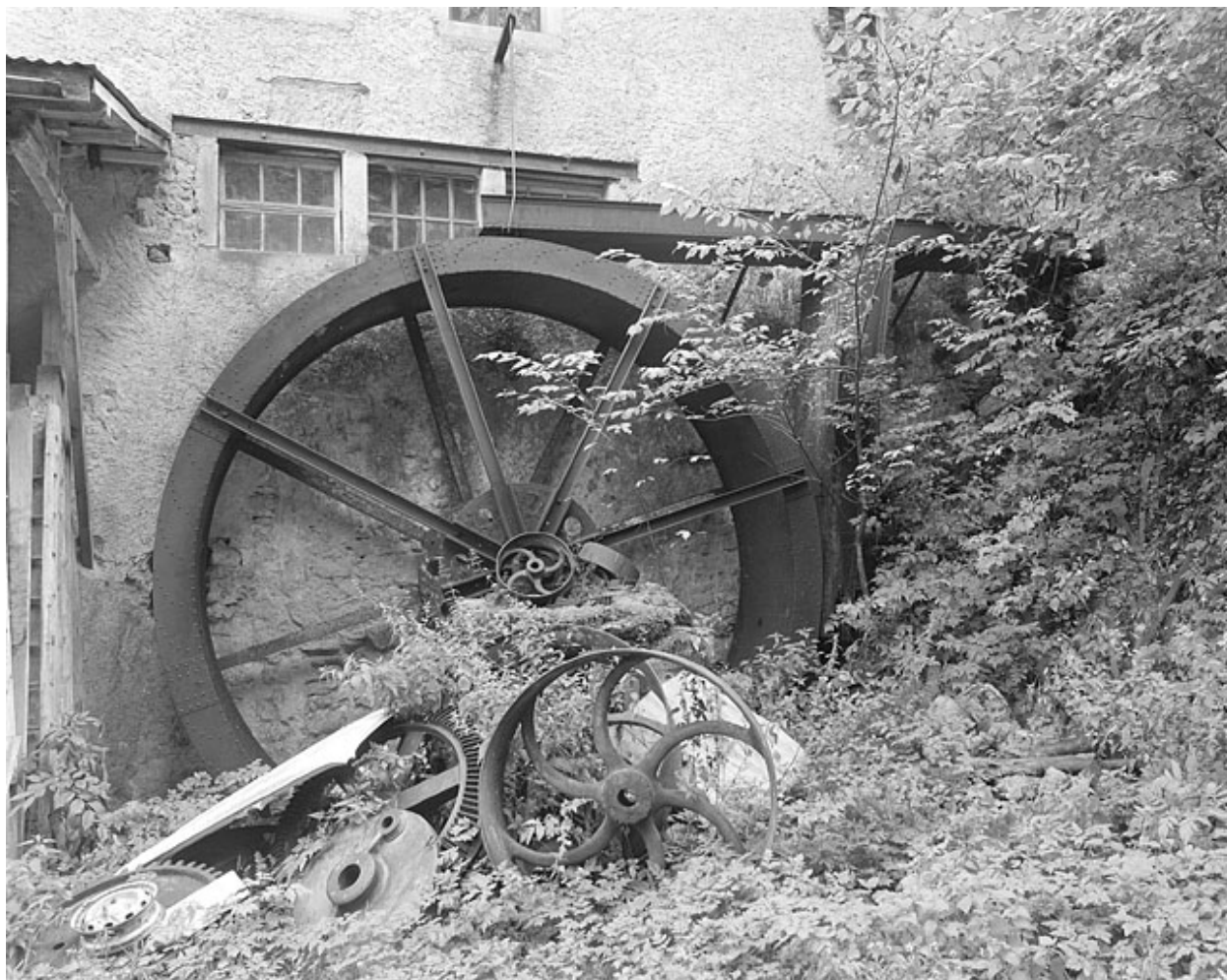
Roue métallique extérieure.
