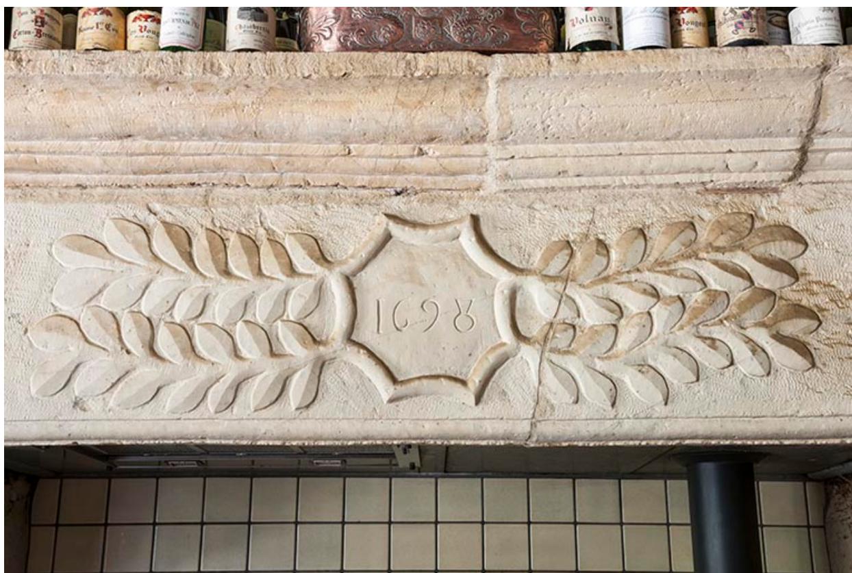
Détail du linteau de la cheminée.
