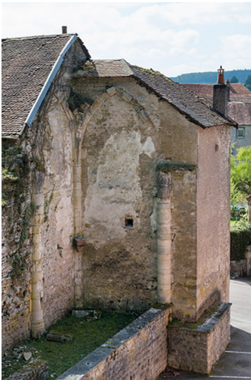
Vestiges de l'ancienne église, rue de l'Eglise.
