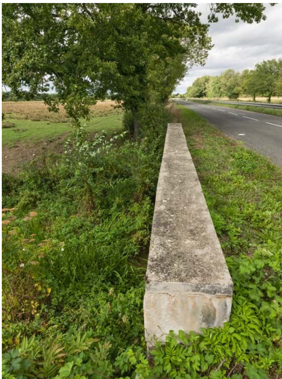
Vue de l'aqueduc.
