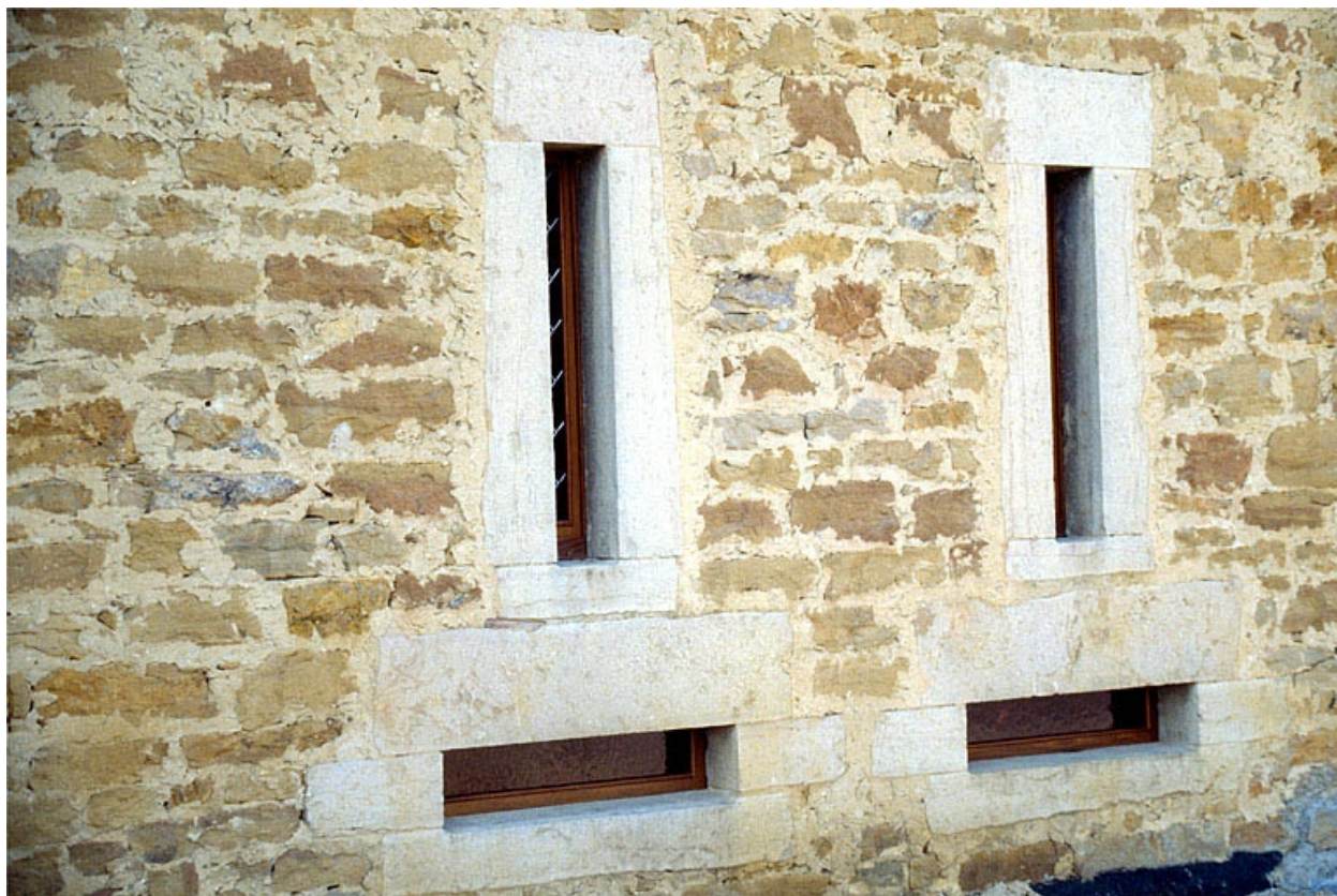
Baies de la chambre à lait.
