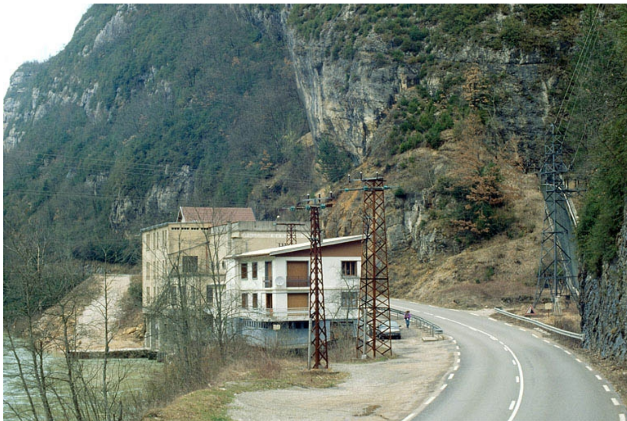
Vue d'ensemble : logement d'ouvriers et centrale.
