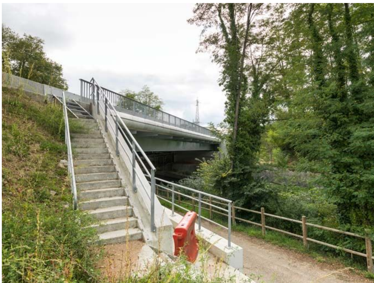
Vue d'ensemble du pont.
