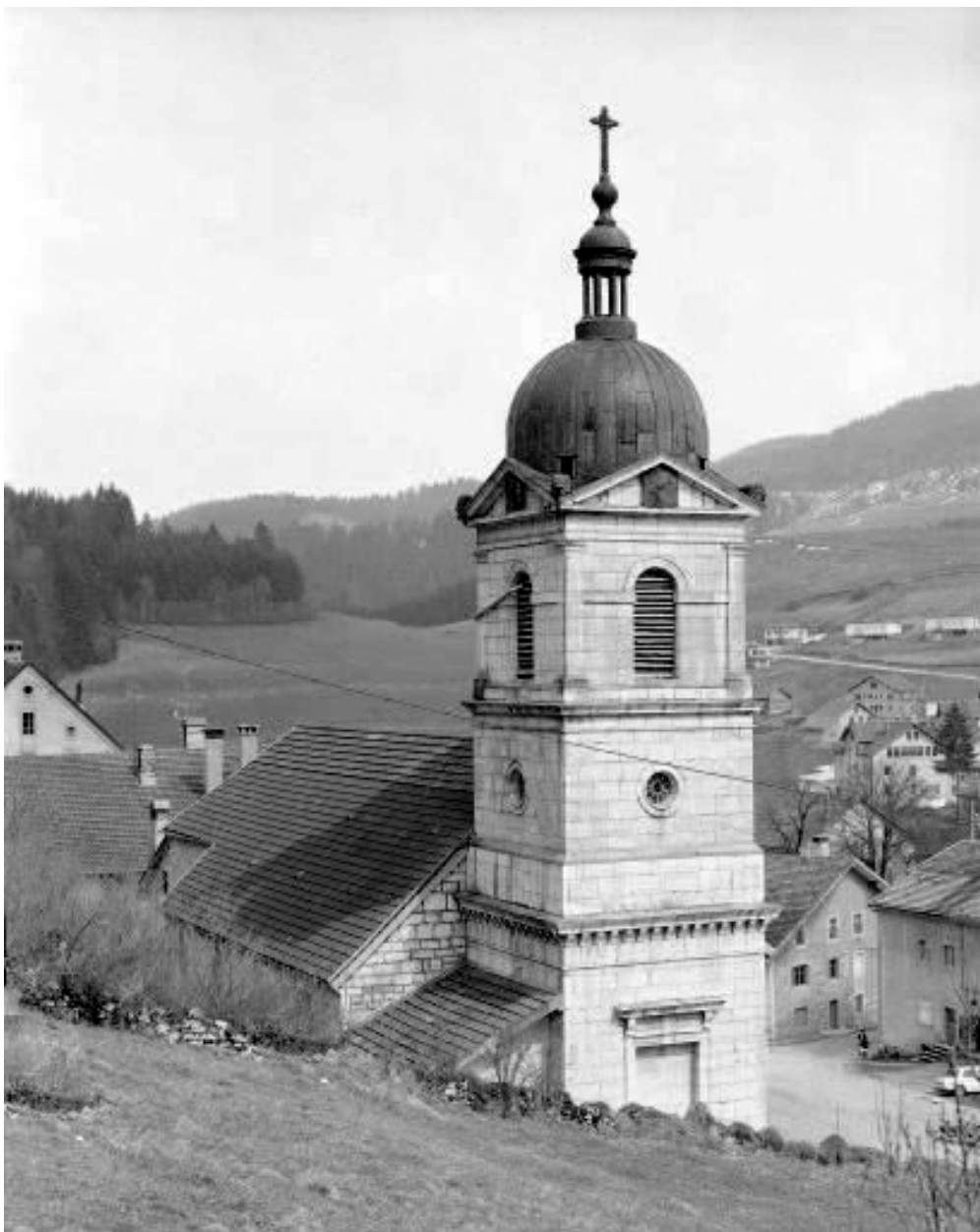
Extérieur : façade antérieure.
