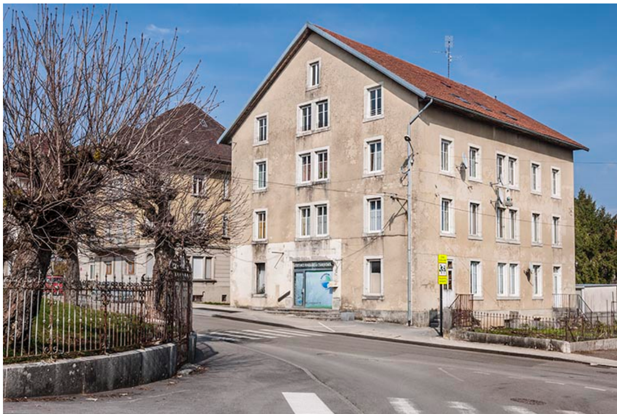
Façades antérieure et latérale droite.
