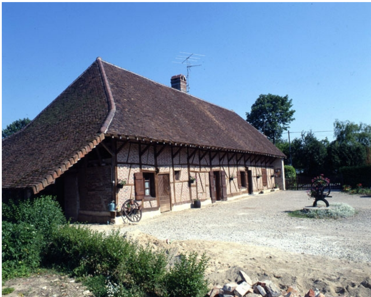
Bâtiment d'habitation : façade antérieure et cour en 1990.
