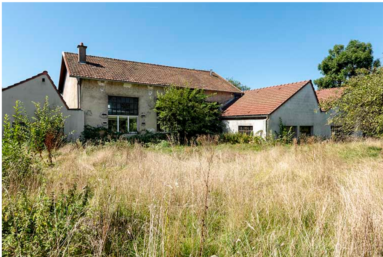
Usine : façade postérieure des ateliers (depuis l'est).
