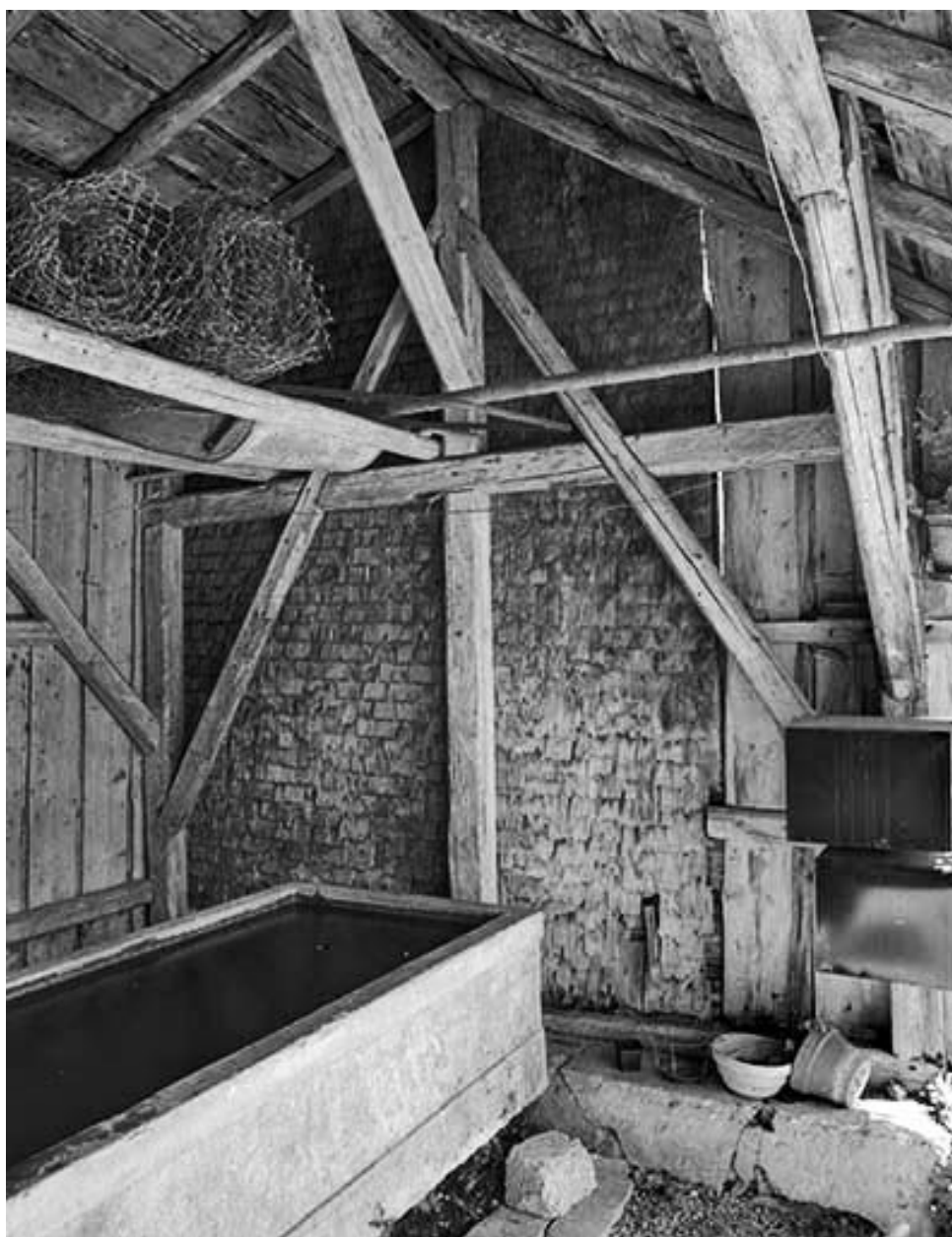
Vue de la charpente.
