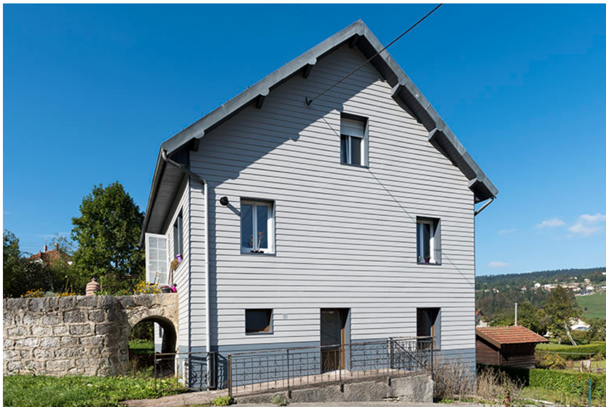
Façade latérale droite.
