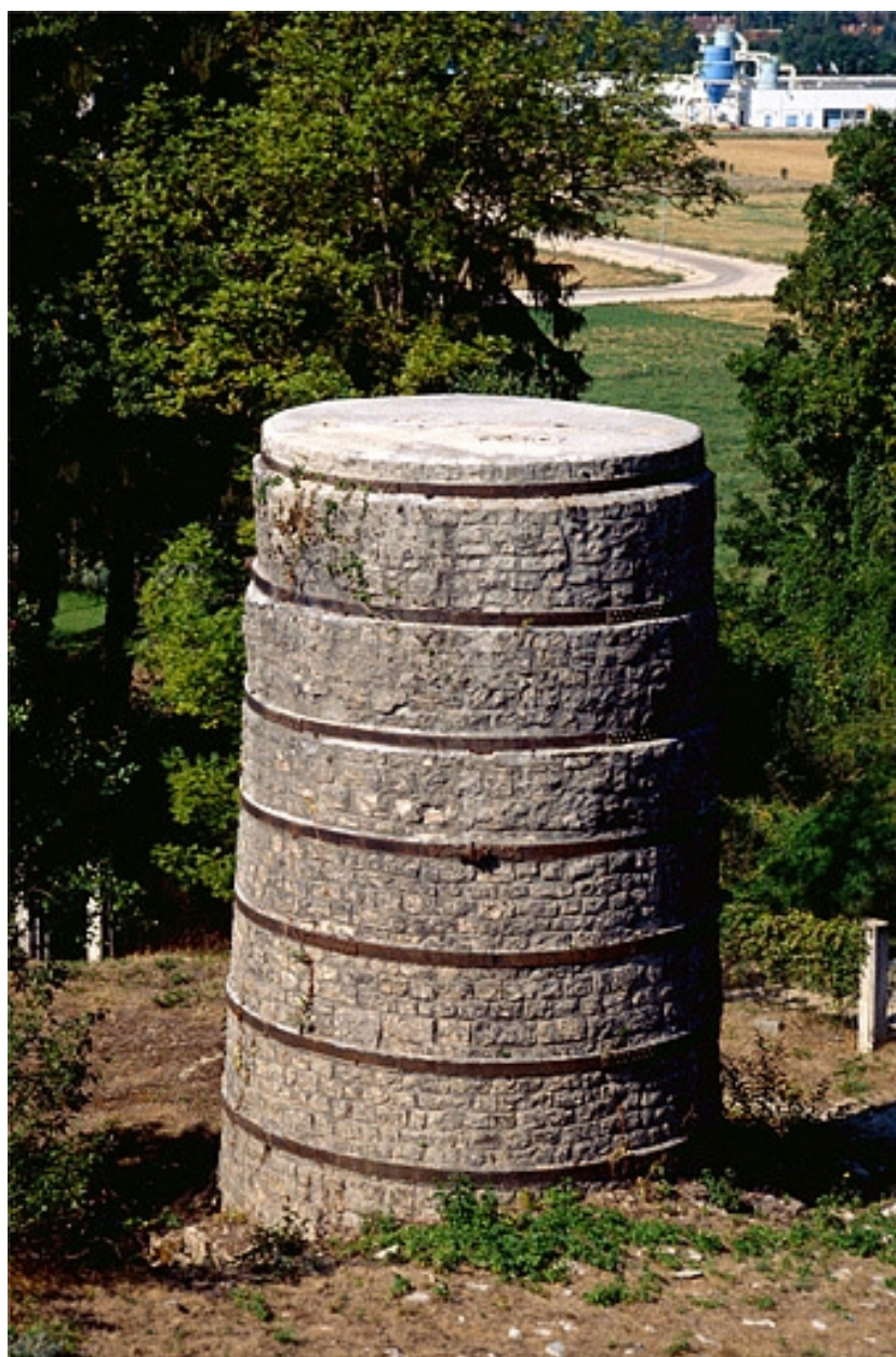
Vue plongeante sur le four à chaux.
