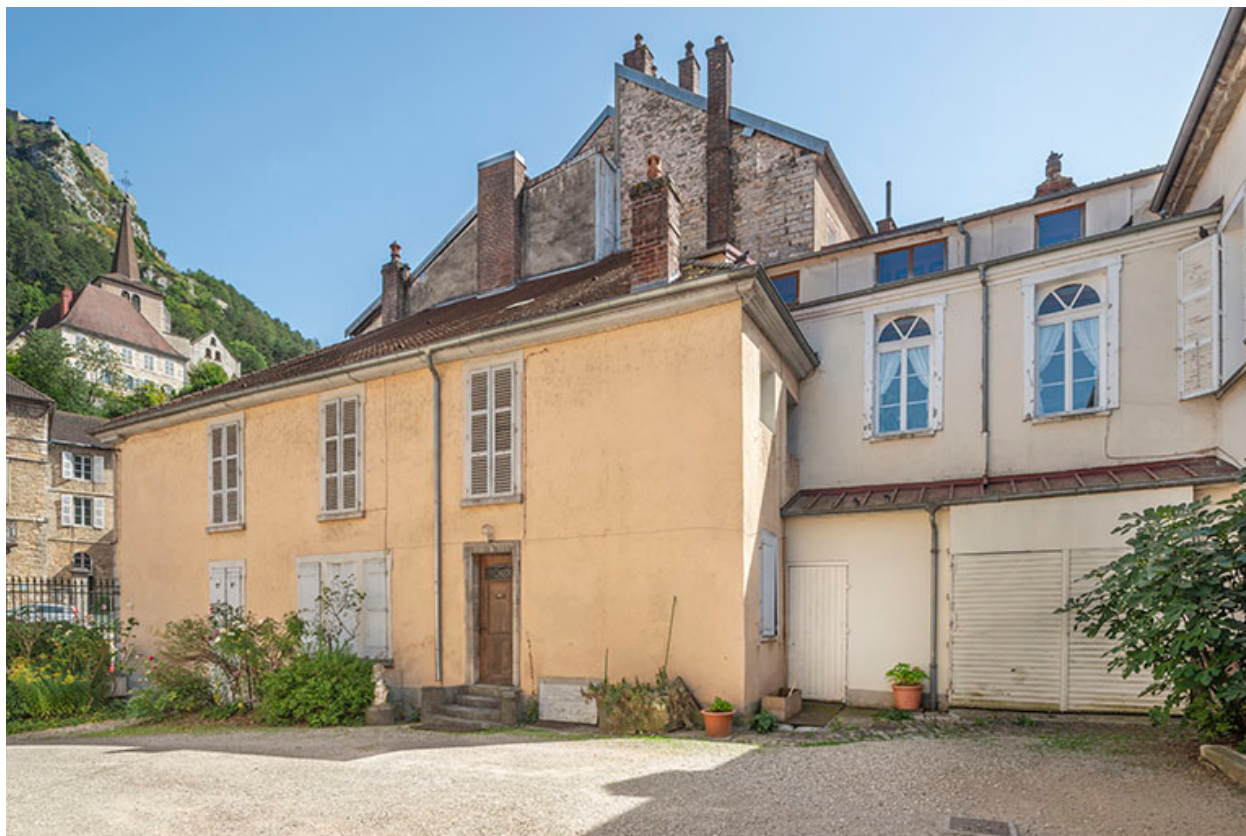
Pavillon sud. Vue de trois quarts.
