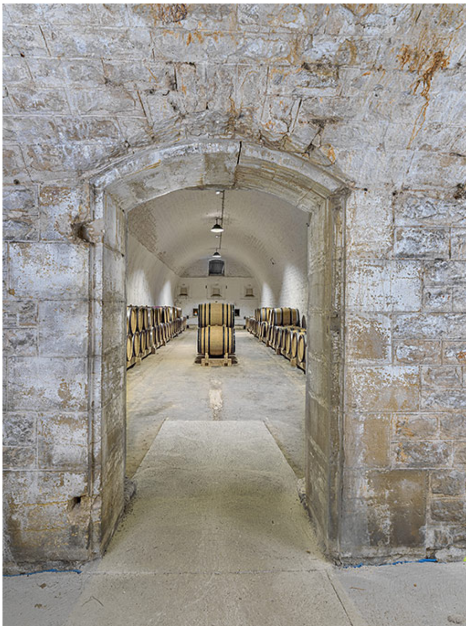
La chambre de stockage : vue depuis le vestibule.
