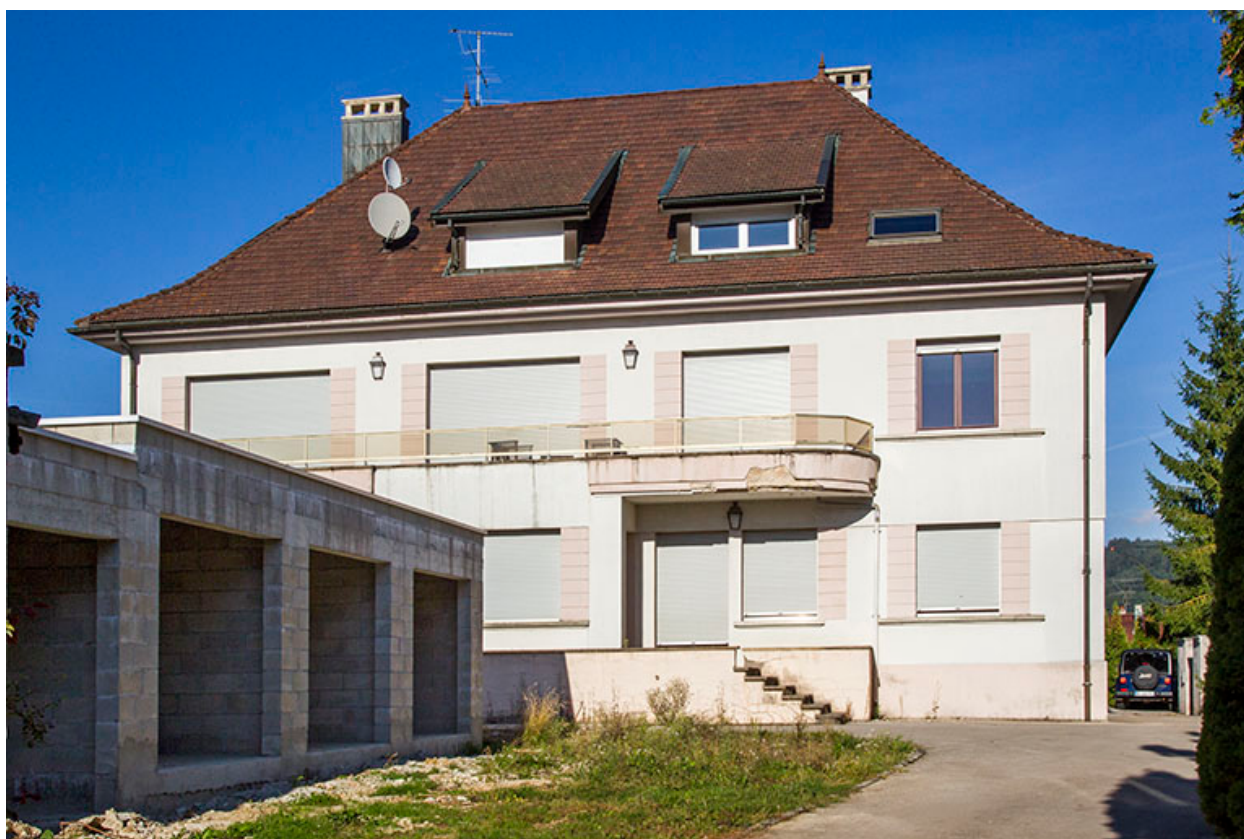
Maison : façade côté usine.
