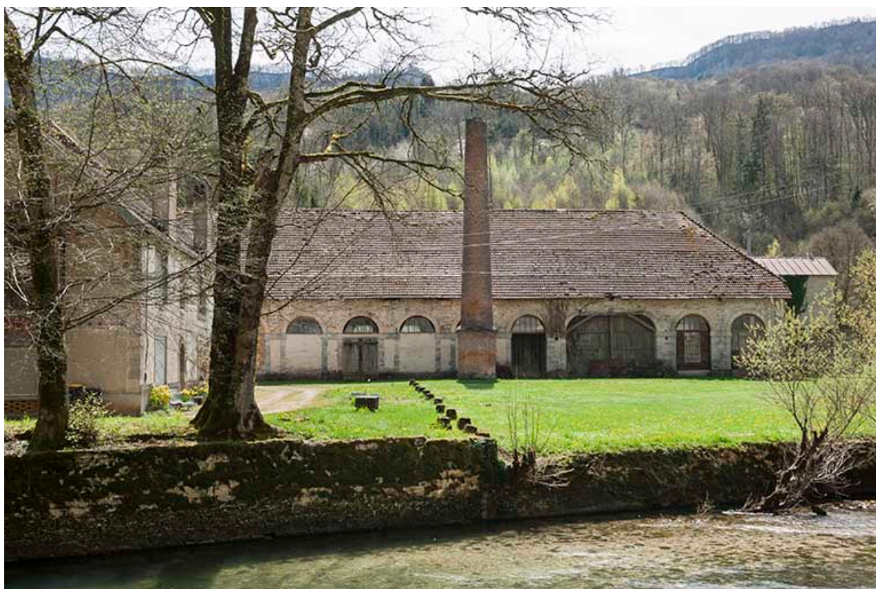
Façade nord de l'atelier de fabrication.
