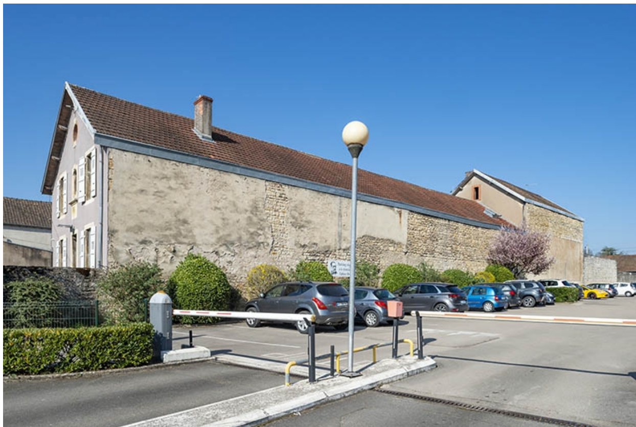
Façade latérale droite.
