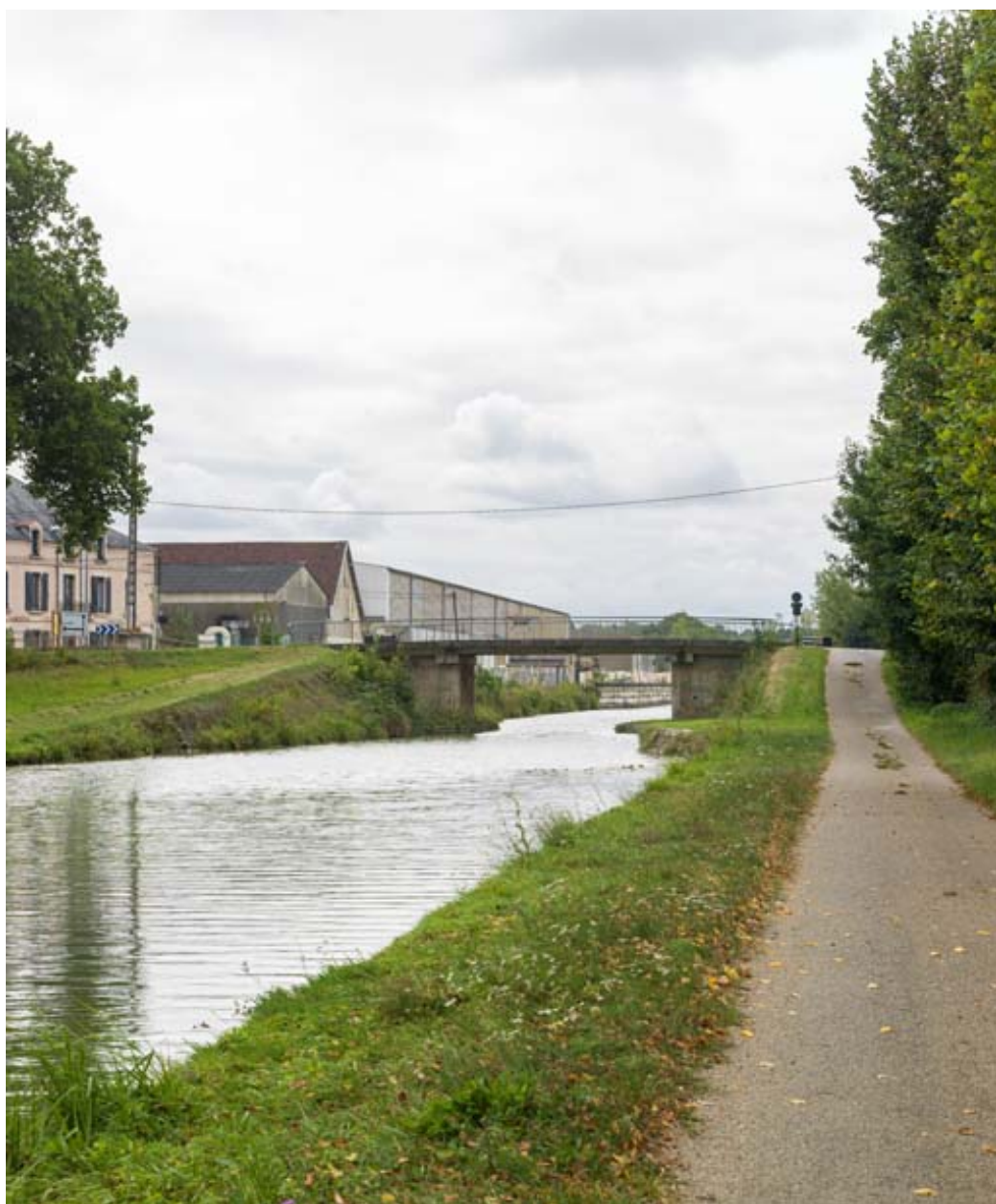
Vue d'ensemble du pont.
