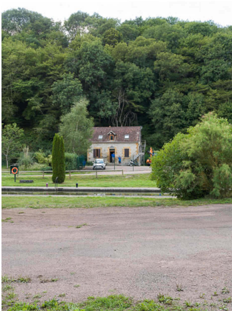
Vue de la maison éclusière.
