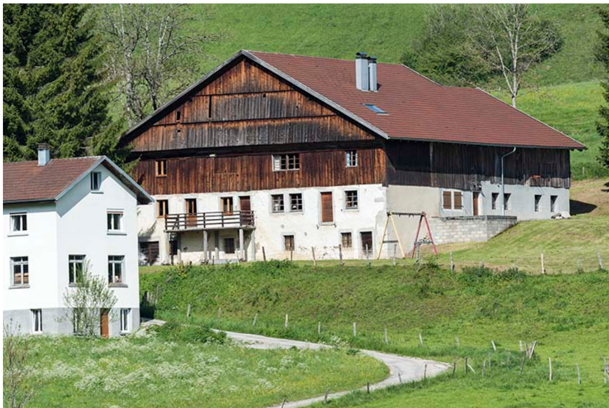
Façades antérieure et latérale droite.
