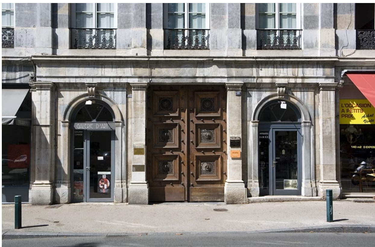
Façade sur rue : détail du portail d'entrée.
