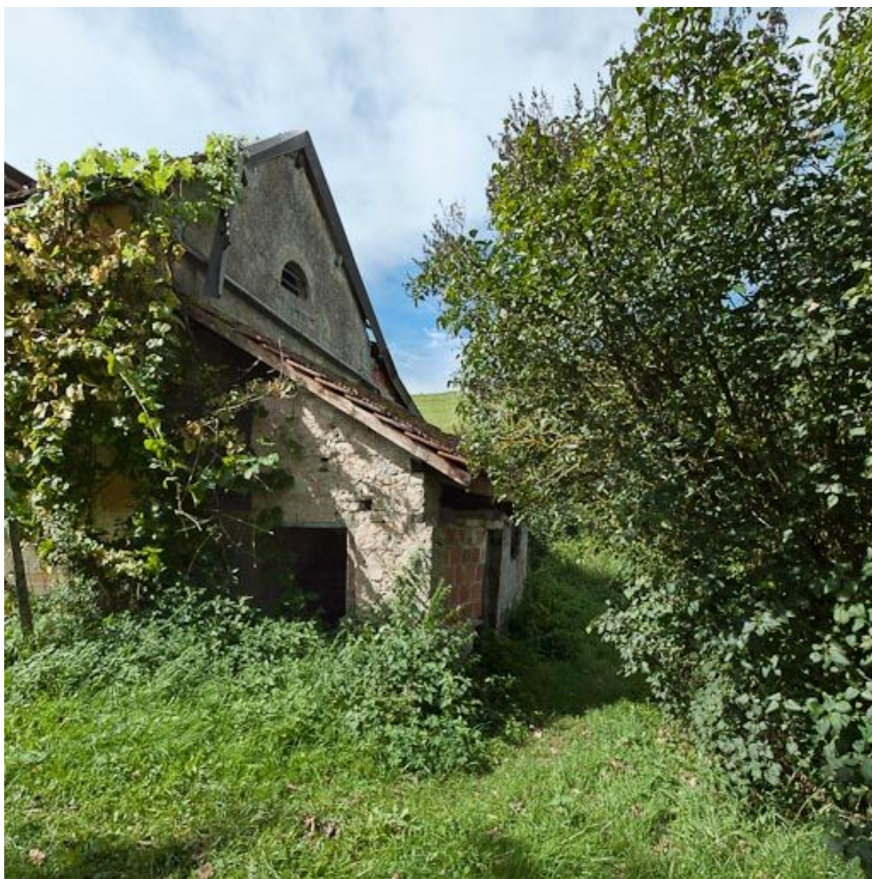
Vue de l'annexe latérale.
