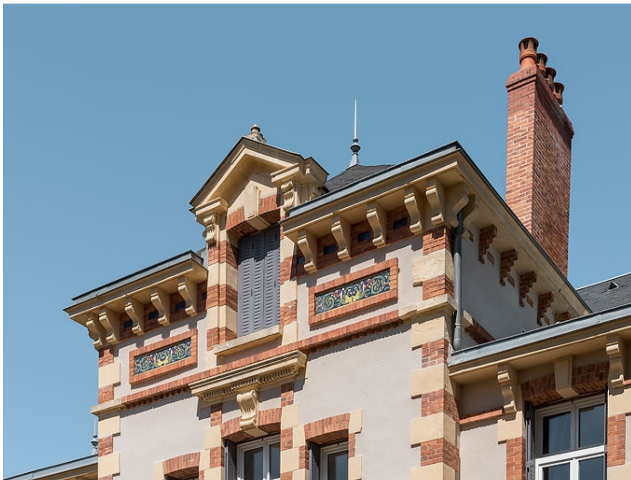
Avant-corps central de la façade principale, détail.
