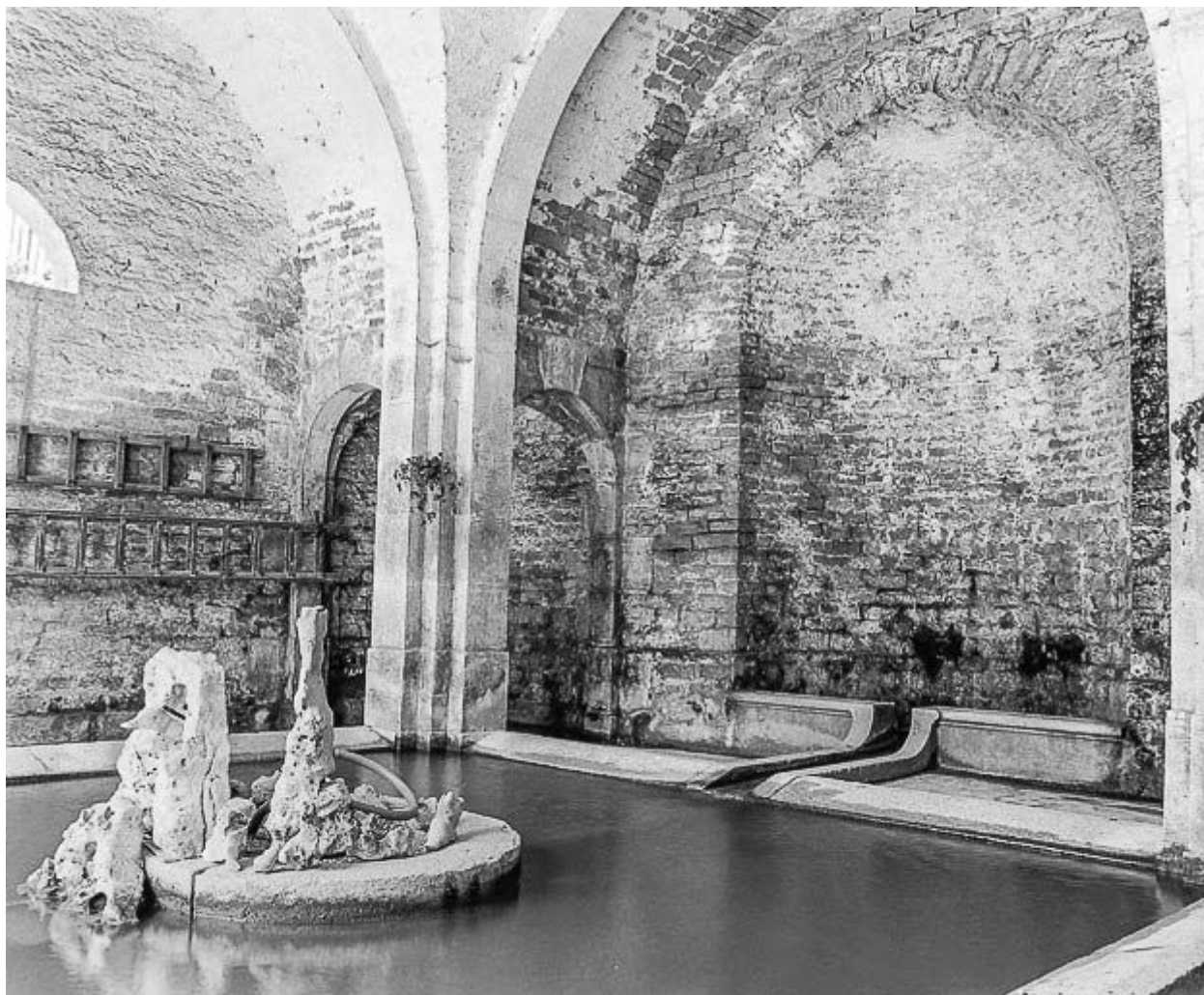
Intérieur : le lavoir.
